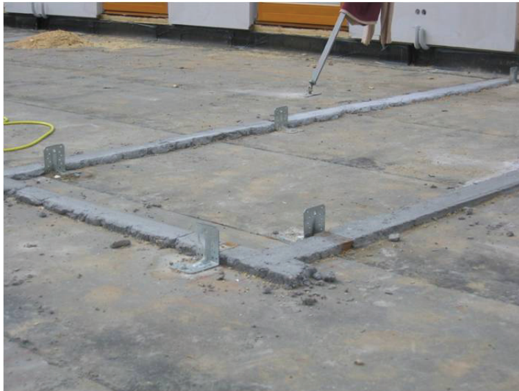
Abbildung 48: durchgehendes Mörtelbett als Toleranzausgleich
