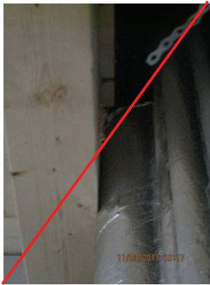
Abbildung 74: Aufgrund einer nachträglichen Vergrößerung des Schachtes ist schachttinnenseitig keine nicht brennbare Bekleidung des hölzernen Unterzuges möglich.
