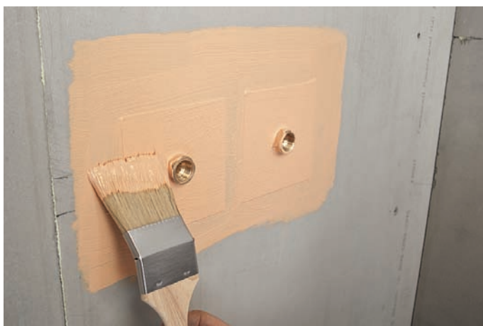
Abbildung 68: Korrekte Ausführung von Armaturdurchdringungen Quelle: Fermacell
