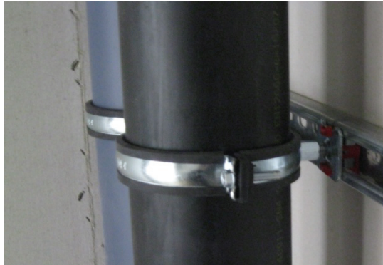
Abbildung 76: Schallschutztechnische Entkoppelung der Rohre
