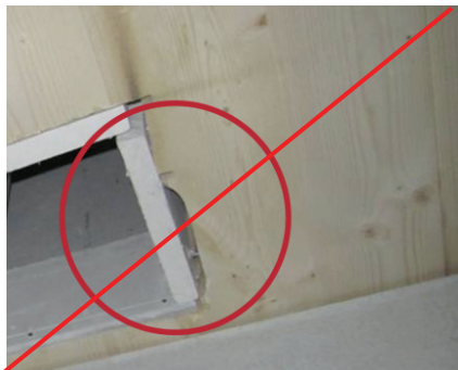
Abbildung 75: Nicht vollflächiger und vollflächiger Einbau der Leibungsverkleidung
