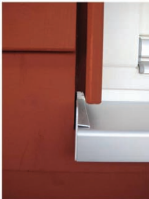
Abbildung 53: Fensterbankanschluß bei Holzfassade
