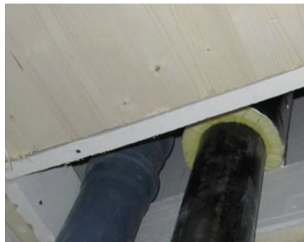
Abbildung 75: Nicht vollflächiger und vollflächiger Einbau der Leibungsverkleidung
