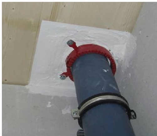
Abbildung 79: Befestigung einer Brandrohrmanschette im Weichschott nur mit durchgehender Befestigung zulässig, siehe rechtes Bild, Quelle: bip
