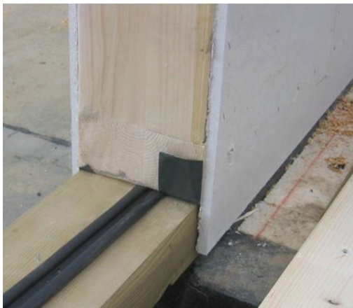
Abbildung 50: Auflagerdetail einer Innenwand unter Verwendung einer imprägnierten Setzschwelle
