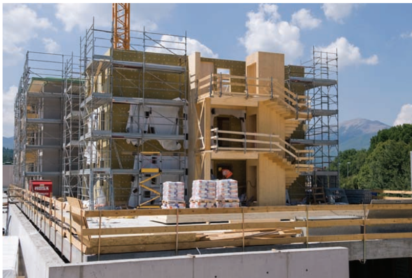
Abbildung 32: Ausführung von Aufzugsschacht Quelle: Binderholz
