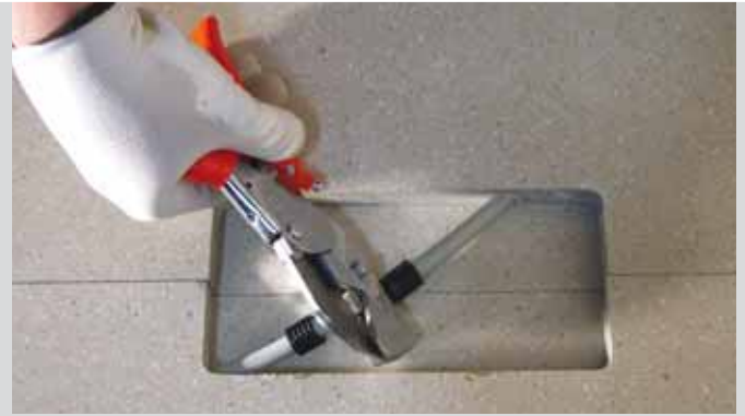
Das Verschließen der Rohrverbindung erfolgt mittels Rohrmontagezange
