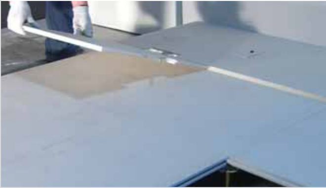
Die Klimatelemente werden auf Knauf GIFAfloor verlegt
