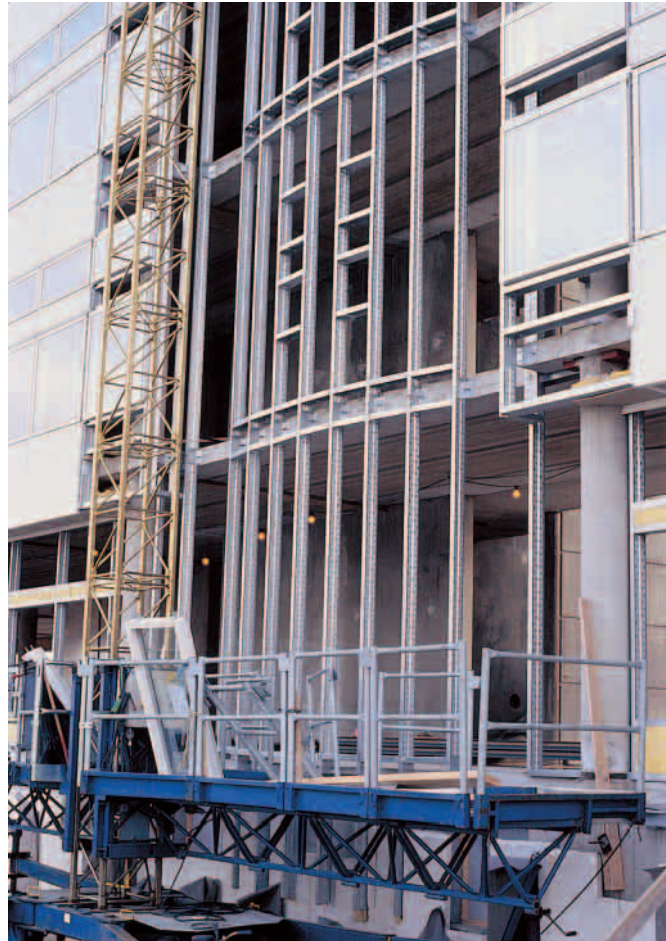
Bild 23: Fassade mit Danogips SBS (Stahlbausystem)
