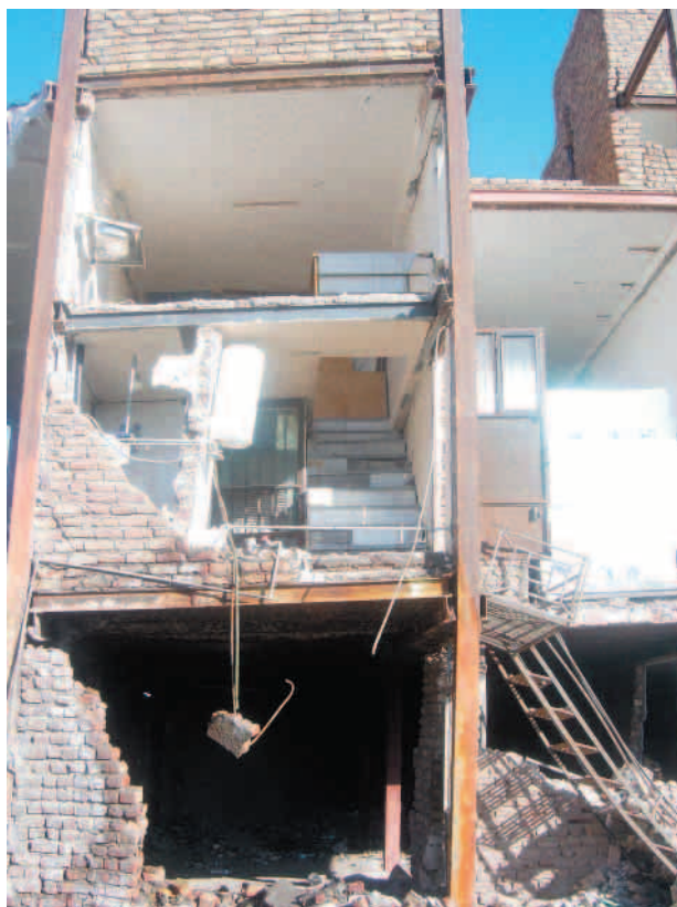
Bild 8: Zerstörtes Füllmauerwerk
