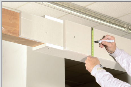
Dosenmontage Holz bekleidet
