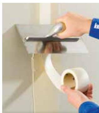
Knauf Fugenfüller leicht mit Papierfugendeckstreifen
