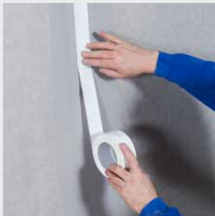
Schritt 2: Knauf Glasfaser-Fugendeckstreifen einlegen
