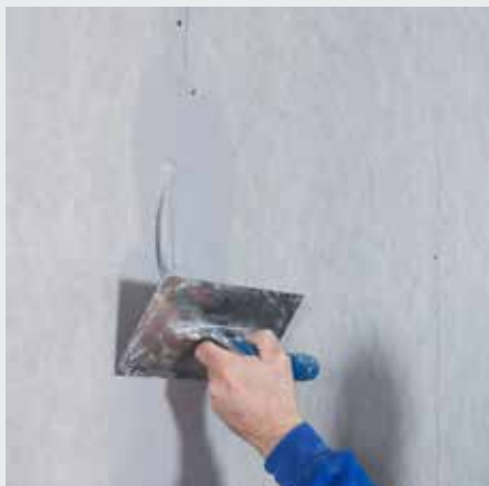
Schritt 1: Fuge mit Drystar-Filler füllen
