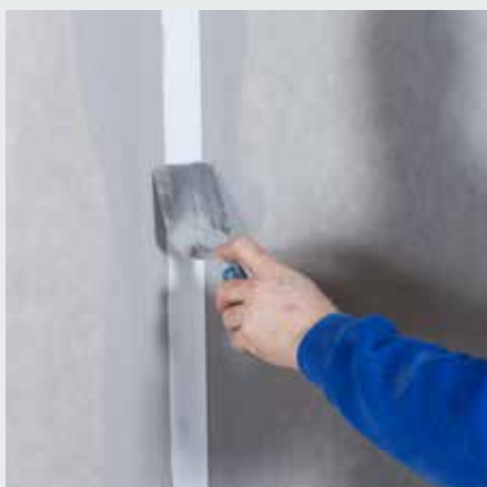
Schritt 3: Knauf Glasfaser-Fugendeckstreifen andrücken
