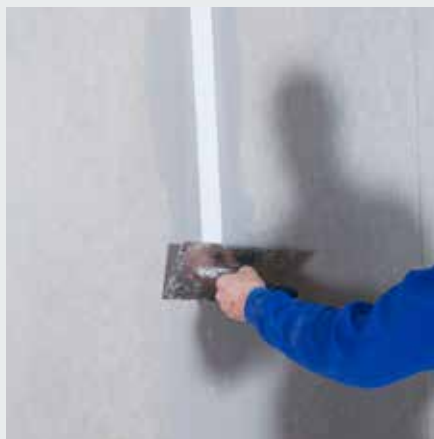
Schritt 4: Fuge nochmals mit Drystar-Filler spachteln
